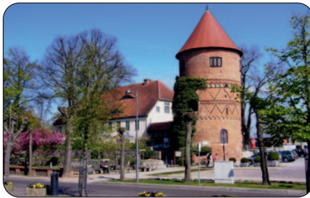
Burgturm in Lübz
